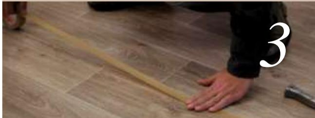
Aplicar fita adesiva ao longo da junta.
