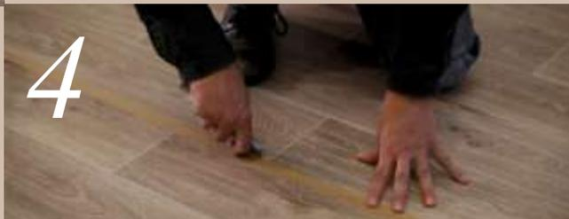
Introduzir a extremidade do bocal na junta e trabalhar para trás, injectando lentamente o fluido até que este transborde para a superfície da fita adesiva de papel. Deixar o fluido de soldadura atuar durante mais de 1 minuto.
