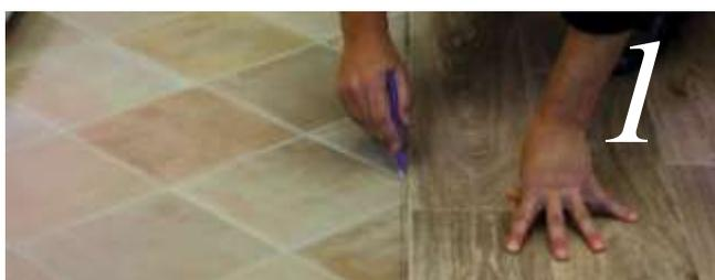
Desenhe uma linha no chão onde será posicionada a junta do revestimento do pavimento.
